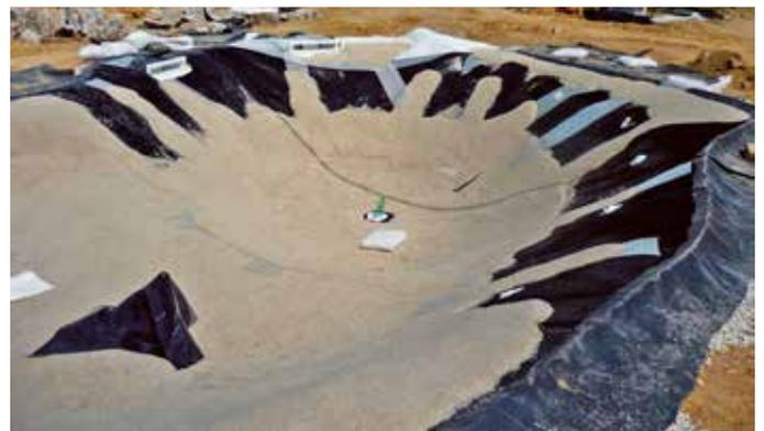
Auf der EPDM-Folie werden sodann die Stein-Resinat-Schichten zur Stärkung der Struktur.
