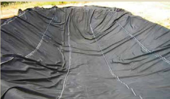
Über die Geotextilie wird eine Abdichtungsfolie aus EPDM verlegt, deren hohe Elastizität sich jeder Bodenbewegung anpasst, ohne Schaden zu nehmen und ohne dass Wasserlecks entstehen.
