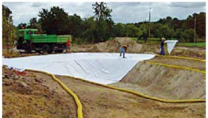
Nach der Platzierung sämtlicher Düsen, die für ein ordnungsgemäßes Funktionieren der Anlagen notwendig sind, wird in der Baugrube ein Schutzvlies aus Geotextilie verlegt, das dazu dient, die Abdichtungsfolie aus EPDM vor möglichen Beschädigungen durch spitze Steine oder Wurzeln zu schützen.
