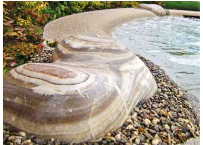
Um Übergangseffekte mit dem Beschichtungsmaterial und natürliche Buchten auf dem Beckenboden zu schaffen, ist in der Projektphase das Einfügen von Dehnfugen ideal, auch um dem Wasser natürliche Farbeffekte zu verleihen. Sie sind auch für die Einfassung der Monolithen entlang des Beckenumfangs außerhalb des Wassers zu empfehlen. In den Durchgangsbereichen sind sie jedoch nicht geeignet. Sie dienen zur Absorption von Dehnbewegungen des Bodenbelags.
